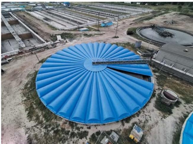
**Рис. 2. Перекрытие первичного отстойника на очистных сооружениях**
