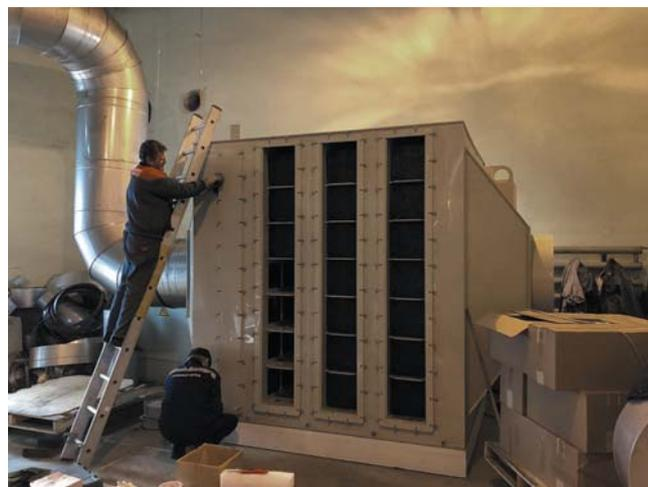
Рис. 5. Адсорбционный фильтр серии АФКТ
