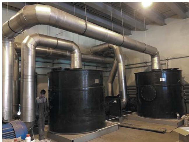
Рис. 6. Адсорбционный фильтр серии ВБС
